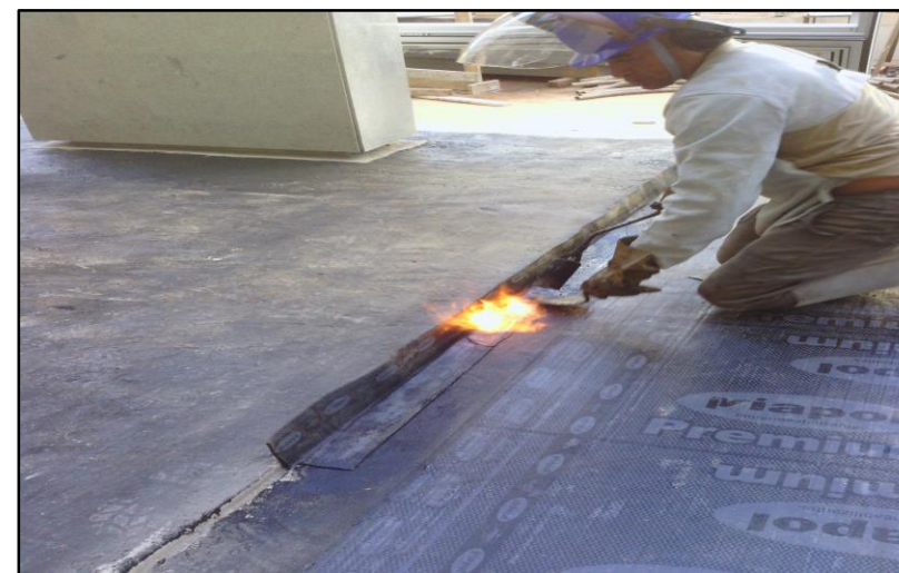
Colagem da manta com utilização de maçarico
