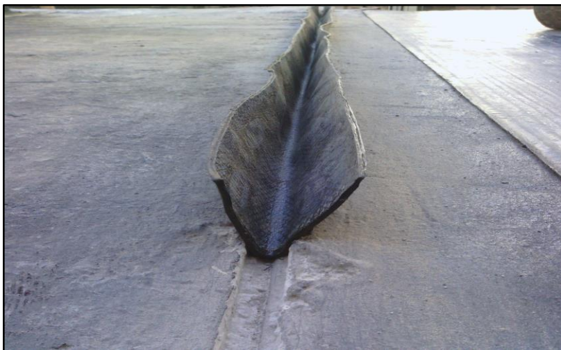
Posicionamento da faixa de manta asfáltica
